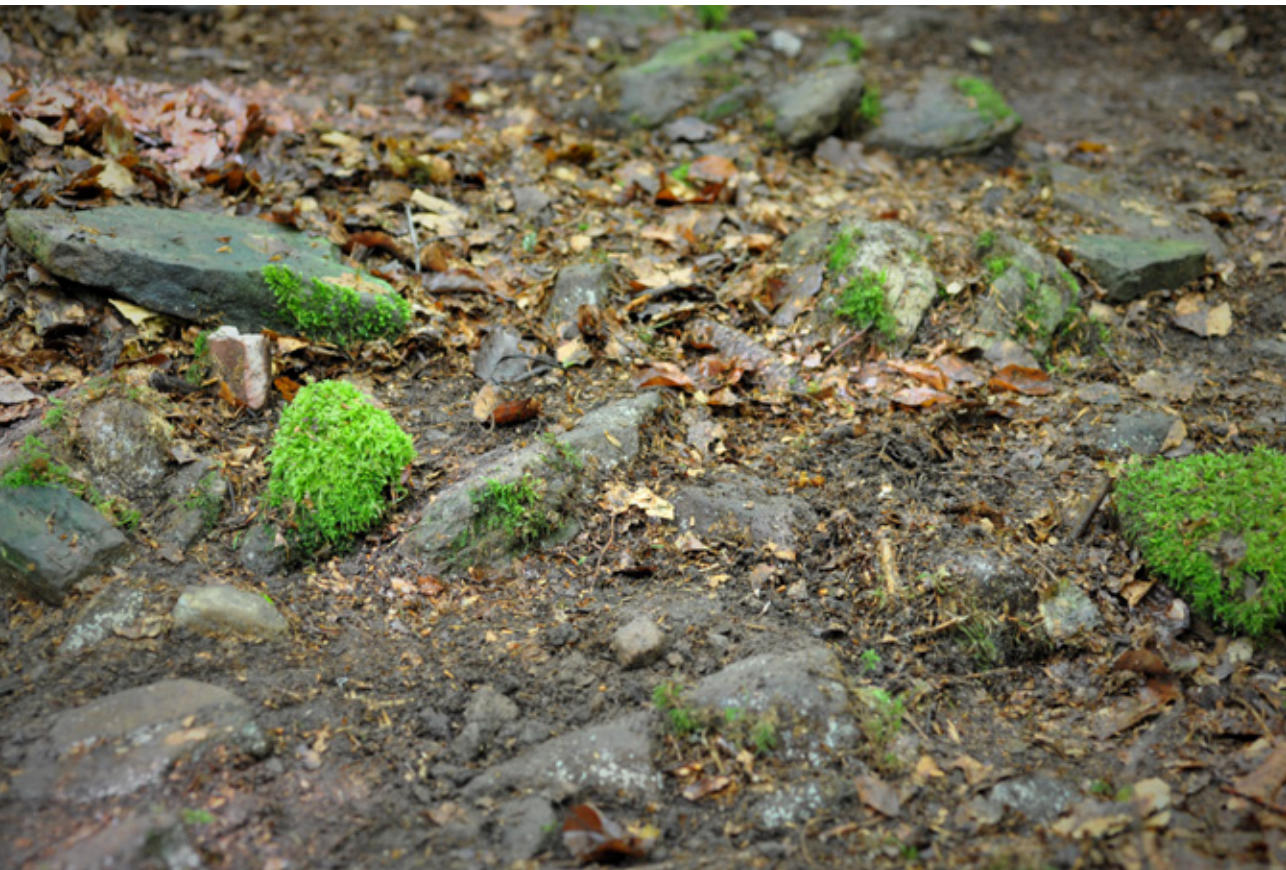
Abb. 11: Unter einer Laub- und Moosschicht sind die Reste des Trassenunterbaus der Dammkrone stellenweise noch gut erhalten.
