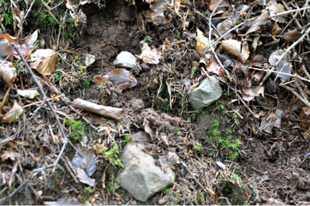
Abb. 10: Erosionskante am Nordufer von Fischbach-1 mit lockerem Steingemisch aus der Trasse (GPS-Wegpunkt 207)
